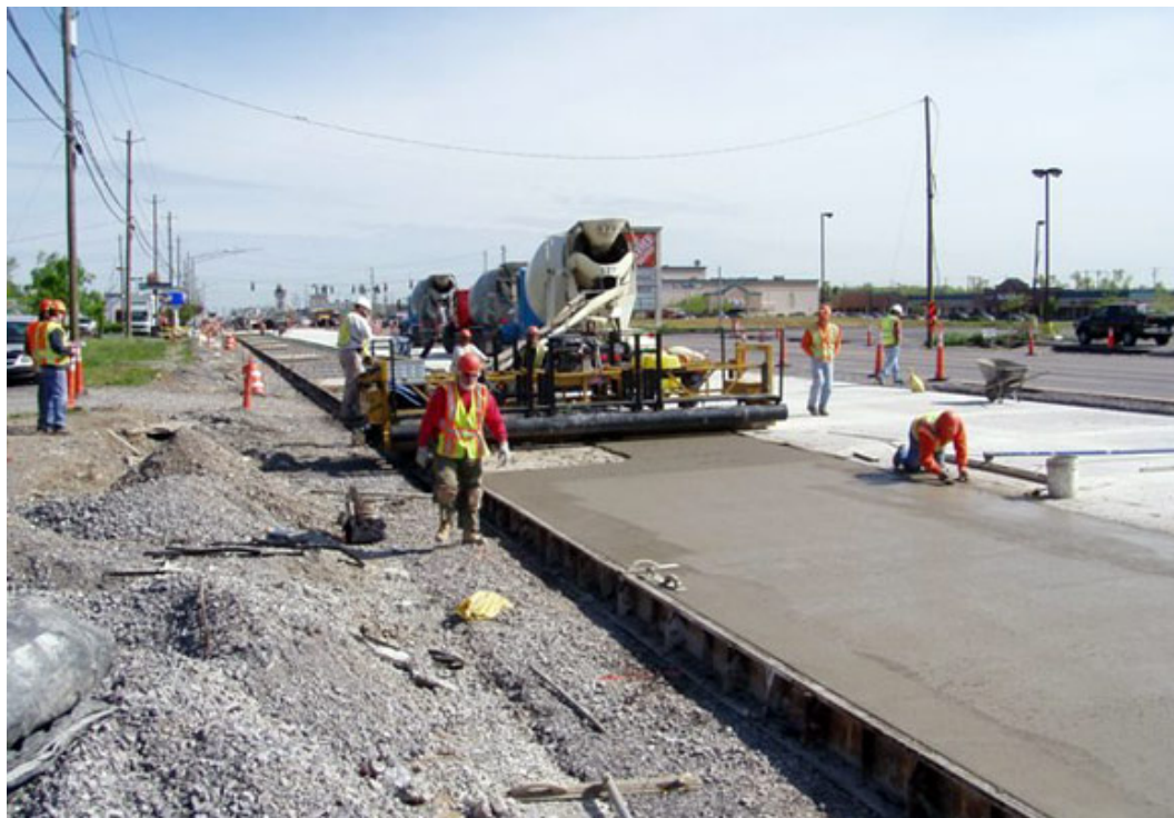
Рис. 2. Укладка дорожного полотна в г. Сочи [5]
