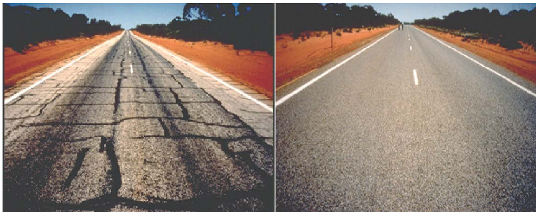
Состояние конструкции покрытия участка автомобильной дороги с применением полимер-битума вяжущего и традиционного асфальтобетона [2]
