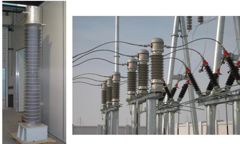
Рис. 8. Электронные ТТ/ТН открытого исполнения
