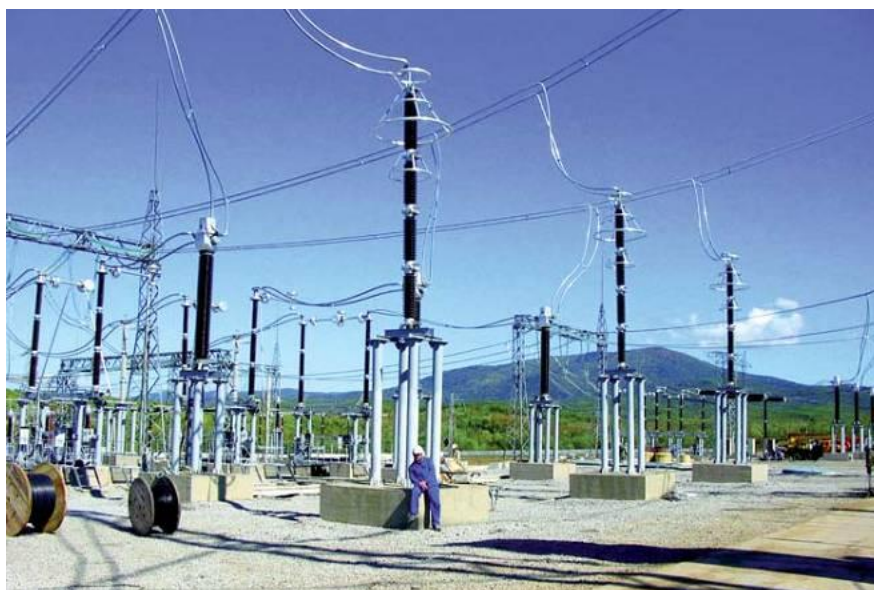
Рис. 1. Цифровая подстанция (общий вид)
