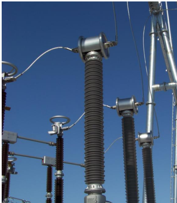
Рис. 10. Оптические трансформаторы тока (220 кВ) в действии
