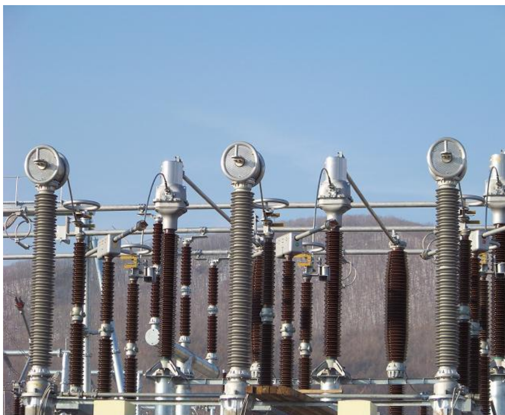
Рис. 11. Оптические трансформаторы тока (110 кВ) в действии
