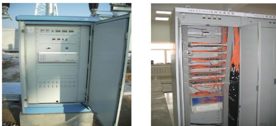
Рис. 5. Интеллектуальный терминал и коммутатор GOOSE
