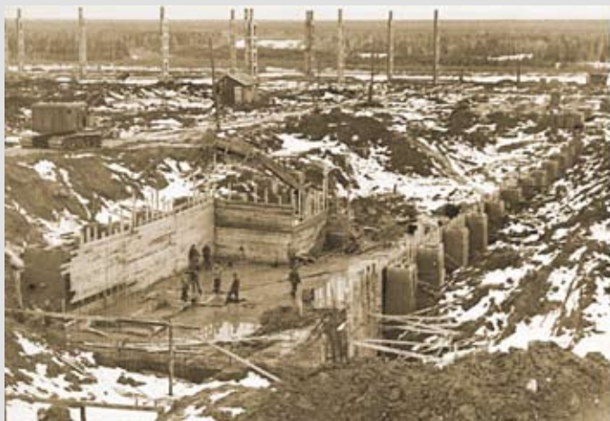
Закладка фундамента под строительство древесно-подготовительного цеха ЛПК. 1964 г.
