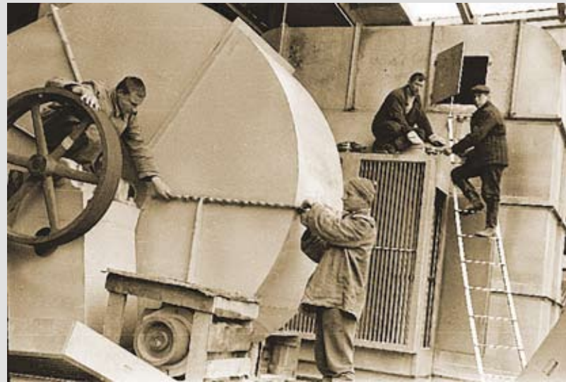
Главный корпус. Идёт монтаж картоноделательной машины. Июнь.
