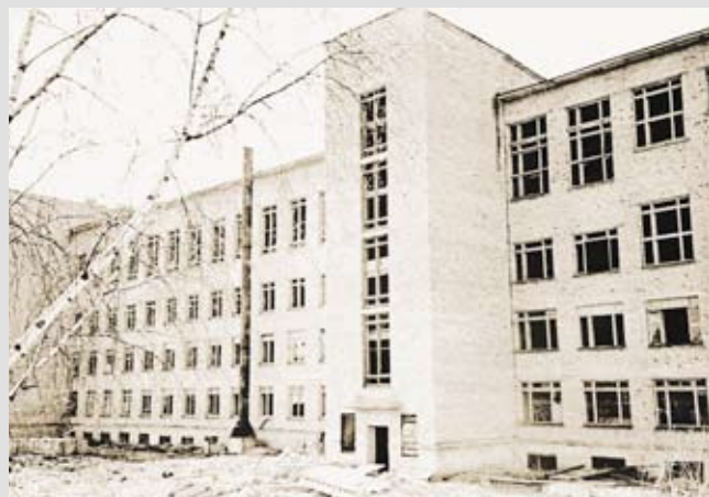
Строительство лесотехнического института. Сыктывкар. Апрель 1967 г.
