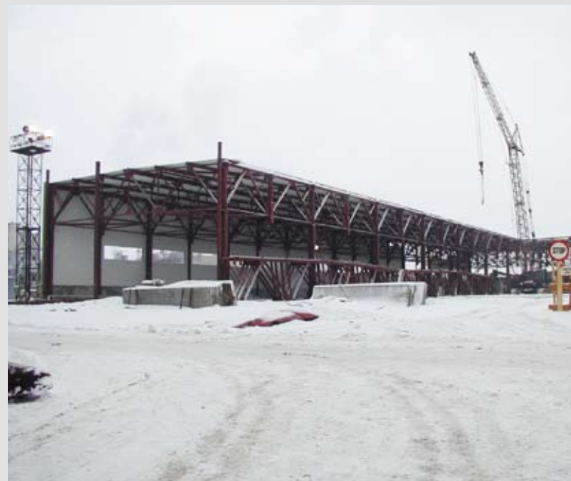
Строительство цеха листовых бумаг № 1 на Сыктывкарском ЛПК – в начальной стадии. 1 января 1999 г.
