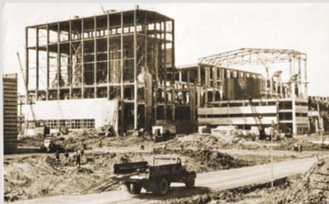
На строительстве главного корпуса ЛПК.
