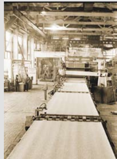
Вторая очередь Княжпогостского завода ДВП введена в эксплуатацию в январе 1976 г.
