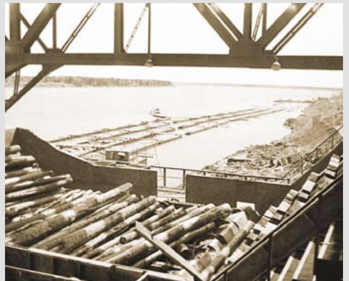
Выкатка сплавной древесины на берегу Вычегды, подача её в древесно-подготовительный цех на распиловку, окорку и рубку в щепу.
