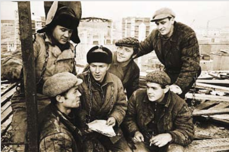
Бригада Ильясова на строительстве главного корпуса.
