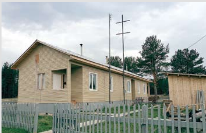
3-квартирный жилой дом, построенный по каркасно-панельной технологии.
