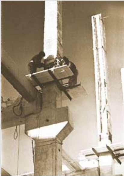
Сыктывкарский ЛПК. Монтаж железобетонных колонн в будущем складе готовой продукции. Февраль 1965 г.
