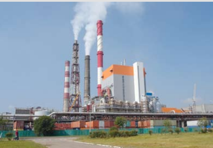
Возведение содорегенерационного котла завершено.
