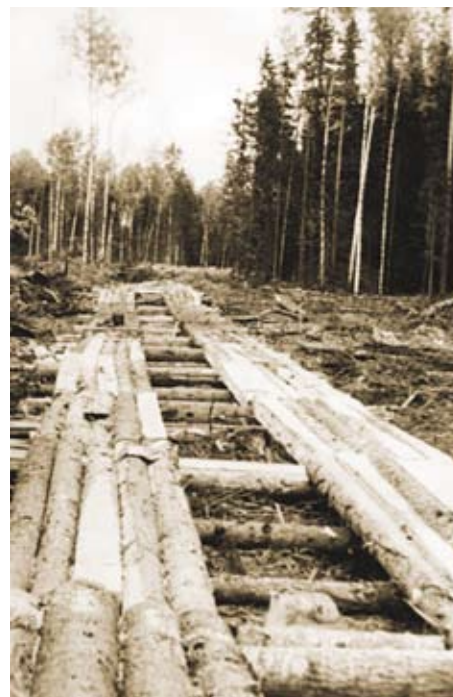
Механизированная укладка нагельных плит. Производительность труда 70-80 м за смену.
