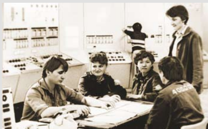
На главном пульте управления цеха по производству термомеханической массы.
