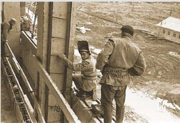
Главный корпус, бригада Беляева ведёт монтаж. Сыктывкар. Июль.
