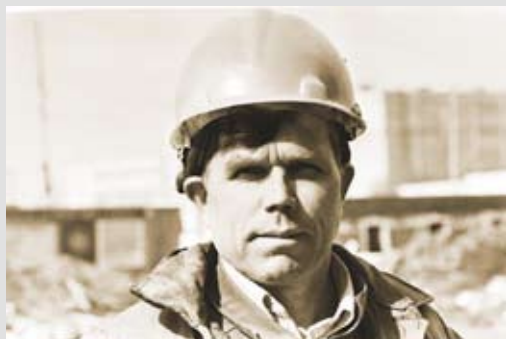
Бригадир комплексной бригады плотников-бетонщиков – бригады коммунистического труда, единственной в управлении СУ-8 треста «Бумпромстрой», – Геннадий Иванович Абашев. Бригада имеет звание «Лучшая бригада Минтяжстроя СССР». Участвовала в возведении второй очереди Сыктывкарского ЛПК и цехов бумагоделательных машин № 4 и № 5. Сыктывкар. 1984 г.
