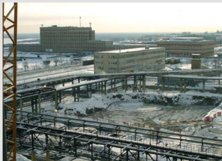
Начало строительства новой выпарной станции по проекту «Степ».
