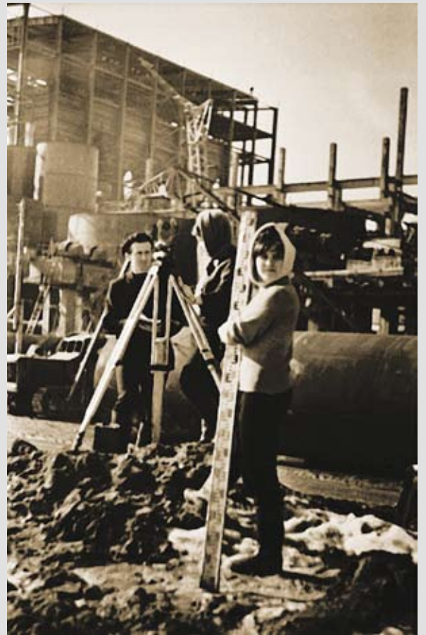
Геодезисты Сыктывкарского ЛПК на строительстве площадки главного корпуса. Май.
