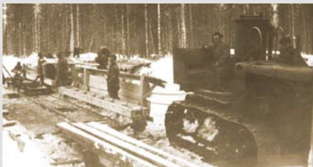
Строительство автолежнёвой дороги в зимний период.
