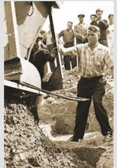
Сыктывкарский ЛПК. Первый бетон для главного корпуса. Август 1964 г.
