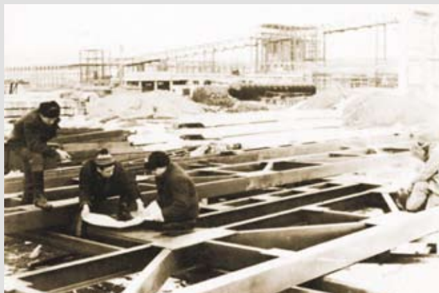
Начинается монтаж оборудования ТЭЦ Сыктывкарского ЛПК. 1967 г.
