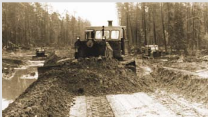
Строительство лесовозной дороги.
