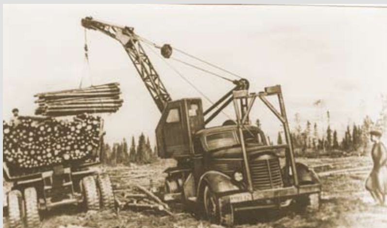
Погрузка леса с помощью подъёмного крана в Мадмаском лесопункте. Усть-Вымский р-н. 1957 г.
