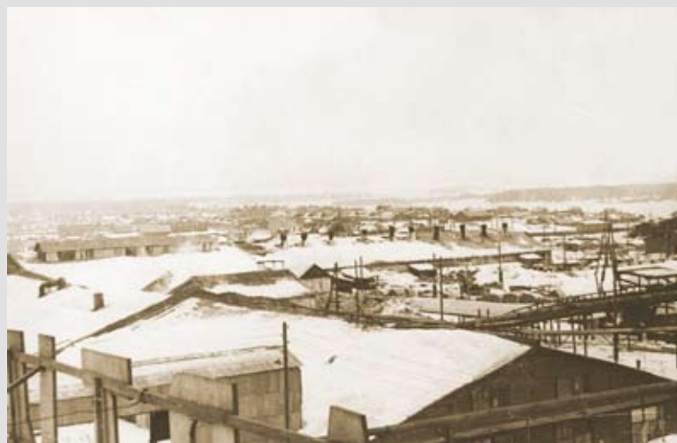
Панорама старого фанерного завода. На переднем плане – галерея-монорельс для перевозки продукции. п. Жешарт, Усть-Вымский р-н.
