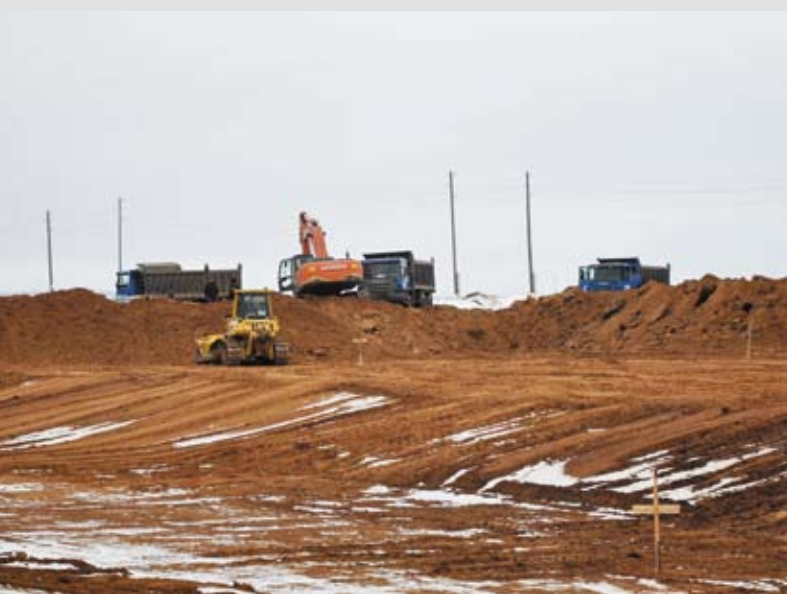
На строительной площадке.
