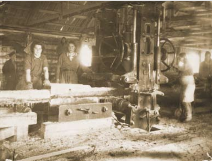
В помещении лесопилки.
