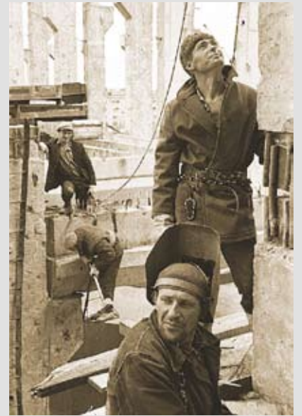
Главный корпус, бригада Суворова ведёт монтаж.
