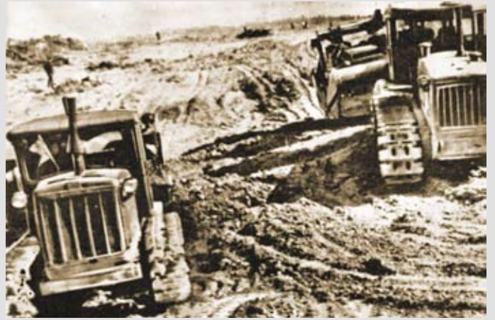
Подготовка строительной площадки. Сыктывкарский ЛПК. Начало 1970-х гг.
