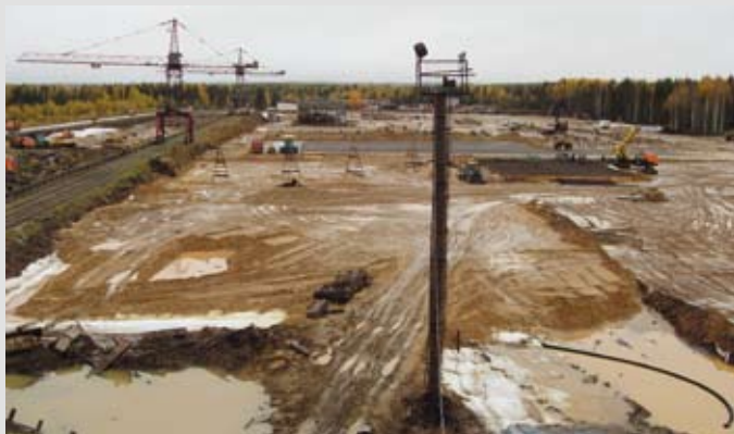
Строительство фундаментов производственных цехов завода. Сентябрь 2009 г.
