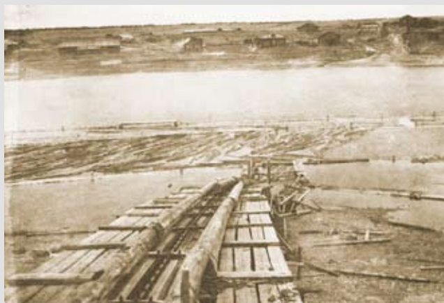
«Бревнотаска» – дощатая дорога для подачи брёвен из воды на склад.
