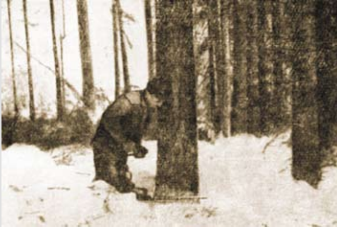
Одиночная валка леса бензомоторной пилой «Дружба»
