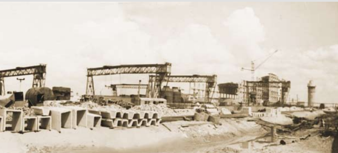
Строительство Сыктывкарского ЛПК. Середина 1960-х гг.
