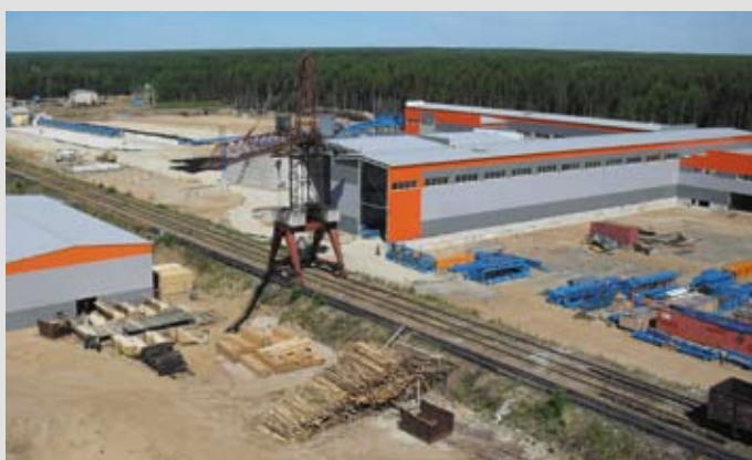
Монтаж оборудования цехов завода. Июль 2010 г.
