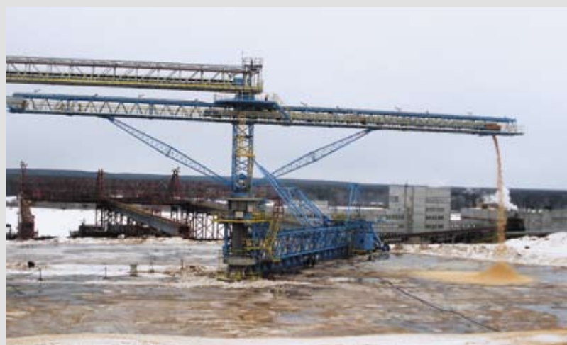
В ОАО «Монди Сиктывкарский ЛПК» получена первая щепа в новом древесно-подготовительном цехе Сиктывкарского ЛПК, построенном в рамках проекта «Степ». 30 марта 2010 г.
