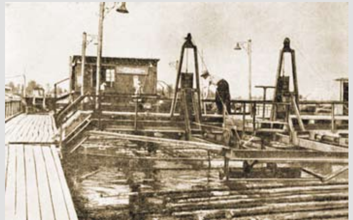
Сплотка леса машиной ЦЛ-2 на р. Сысоле.
