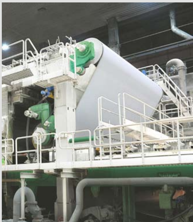
Реконструкция КДМ-21 завершена.
