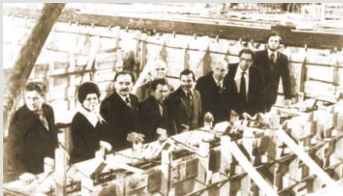
Закладка фундамента под БДМ-4.
