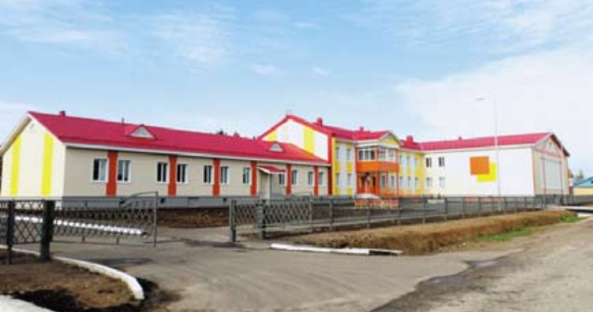
Школа на 200 мест, построенная из массивных деревянных панелей.
