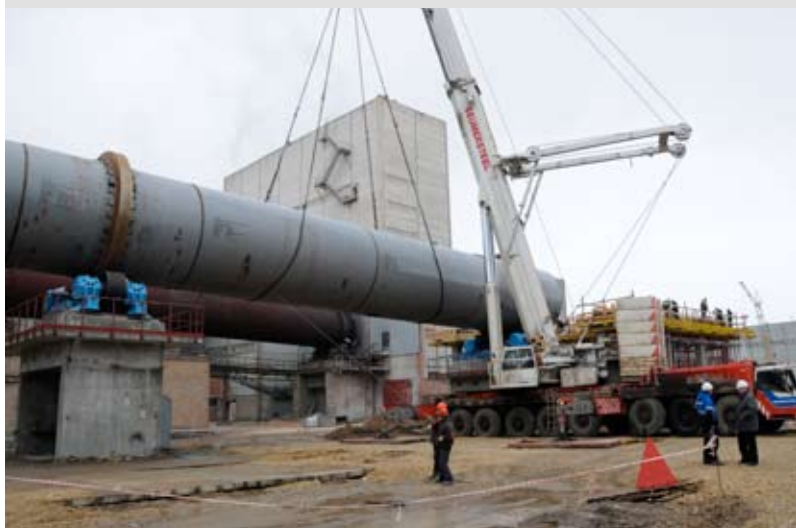
Установка и монтаж известерегенерационной печи.
