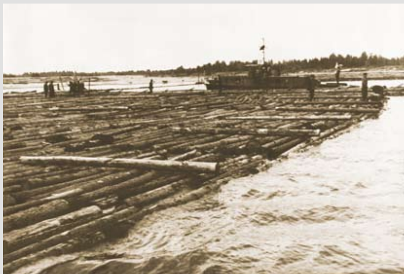
Формировка секционного плота системы «ЦНИИПлесосплава» на Седькыркецком рейде. Сыктывкар. 1955 г.
