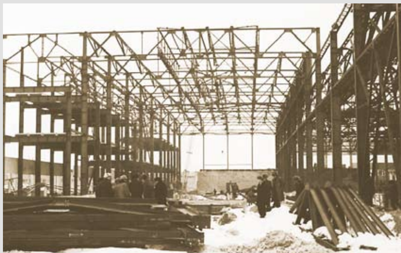
Смонтированы металлоконструкции средней части главного корпуса. В настоящее время здесь расположен главный конвейер производства ДВП СП.
