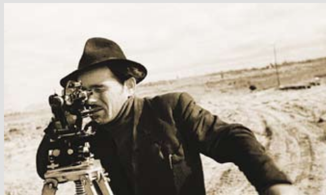
Инженер-геодезист Карасов Г.А. за разбивкой корпусов первого объекта корпуса ЦРМ. Сыктывкарский ЛПК. 1963 г.
