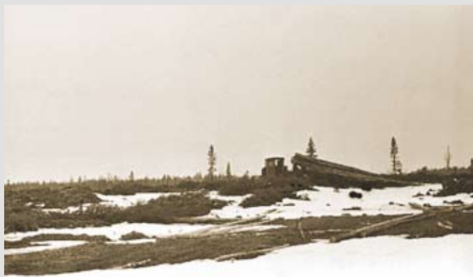
Расчистка территории под строительство Сыктывкарского ЛПК. Сыктывкар. 1960 г.
