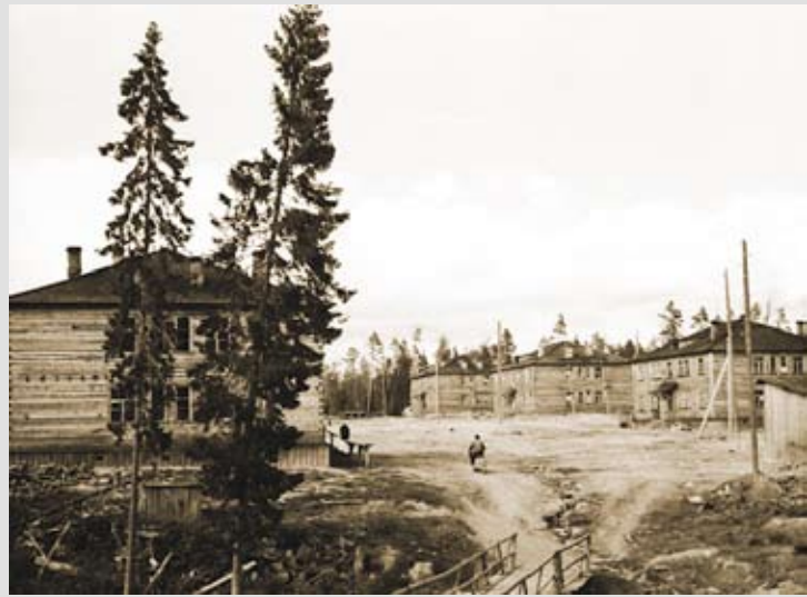
Посёлок Якинского лесопункта. Посёлок Троицко-Печорск, Троицко-Печорский р-н. 1965 г.
