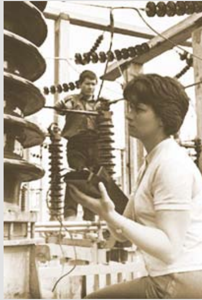
Монтаж открытого распределительного устройства ТЭЦ.
