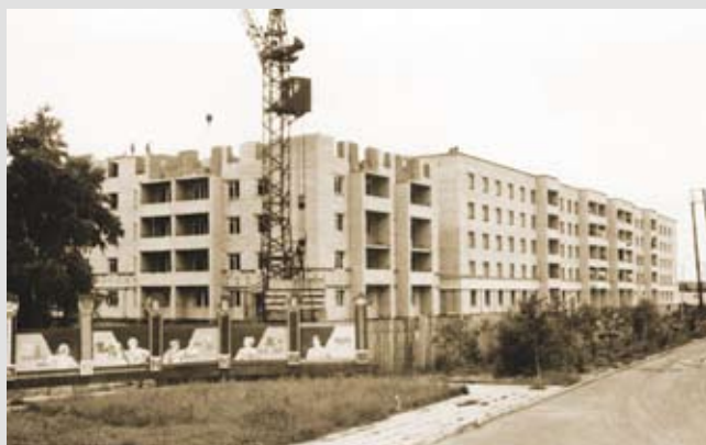
Строительство микрорайона № 3 жилого массива Княжпогостского завода ДВП. 1980 г.
