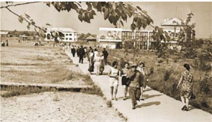
Идёт рабочая смена Жешартского фанерного завода. Посёлок Жешарт, Усть-Вымский р-н. 1970 г.
