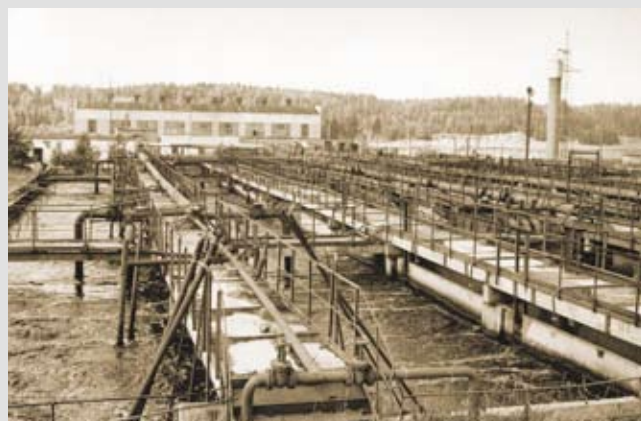
Очистные сооружения Княжпогостского завода ДВП. Первая половина 1980-х гг.
