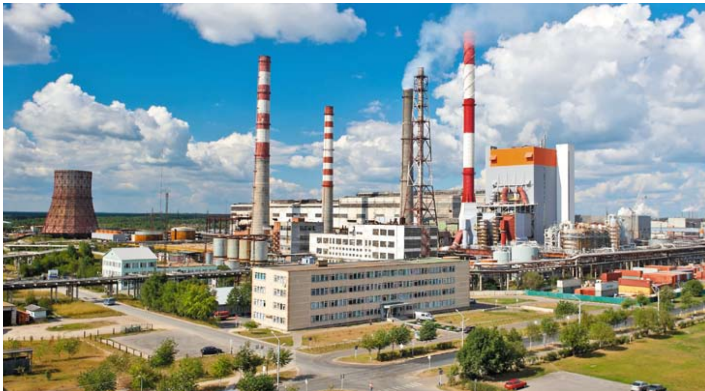
Вид на ТЭЦ и соререгенерационный котёл Сыктывкарского ЛПК.
