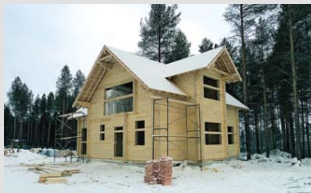
Строительство жилого дома из клеёного бруса.
