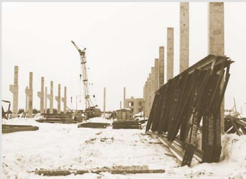
К строительству нового корпуса ДСП-250 фанзавода приступили в 1975 г.
