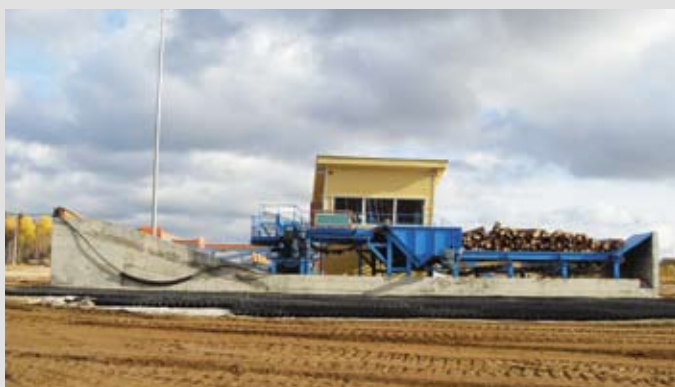
Завершение монтажа оборудования линии сортировки пиловочника цехов завода. Сентябрь 2009 г.
