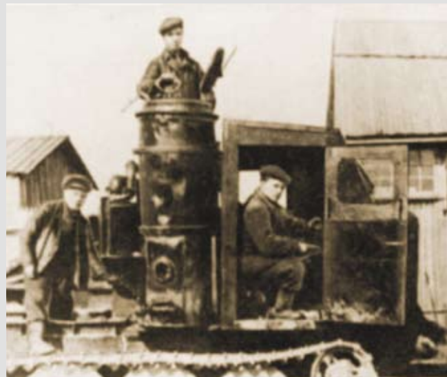
Трактор КТ-12, работавший на твёрдом топливе (газочурках). 1950-е гг.
