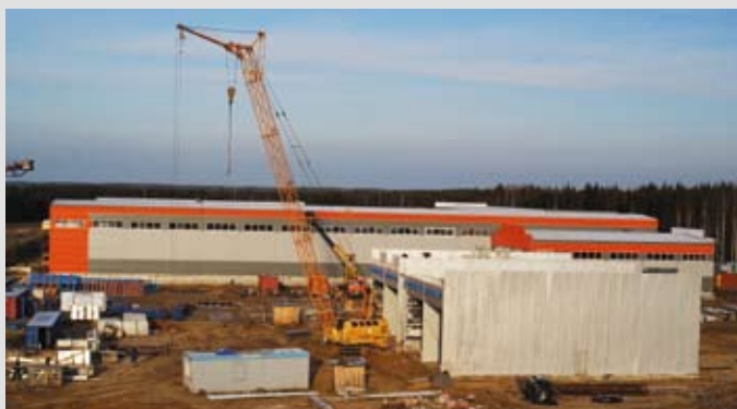
Монтаж оборудования сушильного комплекса пиломатериалов цехов завода. Октябрь 2010 г.
