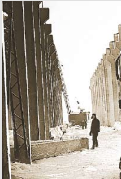
Сыктывкарский ЛПК. Монтаж межэтажных перекрытий главного корпуса. Февраль 1965 г.
