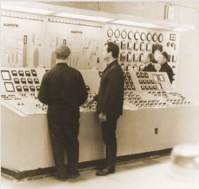
Пульт управления варочного цеха картонно-бумажной фабрики.
