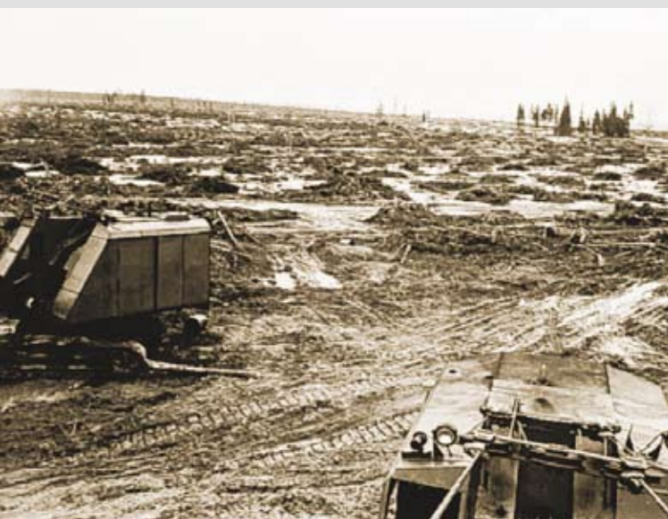
Место будущего главного корпуса Сыктывкарского ЛПК. Апрель 1964 г.
