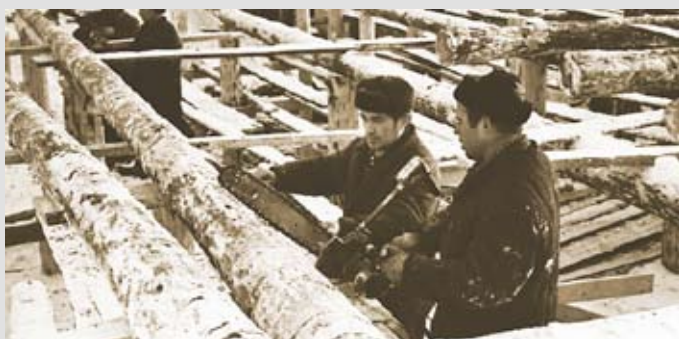
Ухтинский ЛПХ. Строительство новой разделочной площадки. Ухта.
