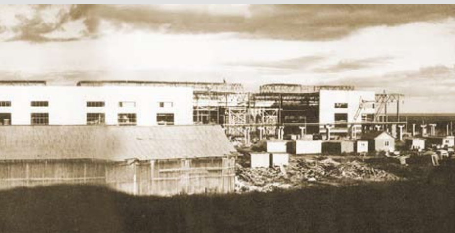
Строительства комплекса ДСП-250.
