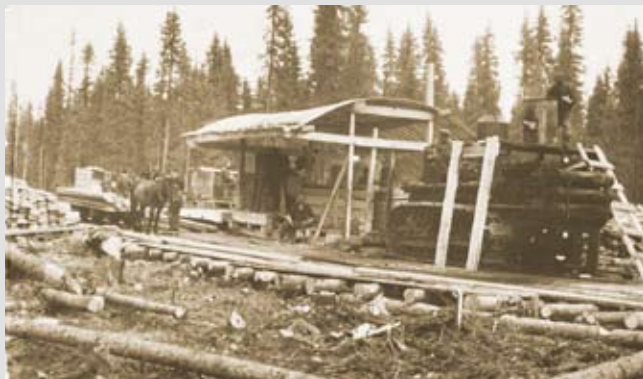
Строительство автолежнёвой дороги в летний период.
