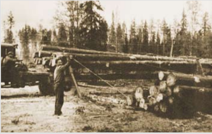
Погрузка леса на автомашину МАЗ-501 лебедкой ЛК-8 пачками способом накатывания. Каджеромский лесопункт. Печорский р-н. 1968 г.
