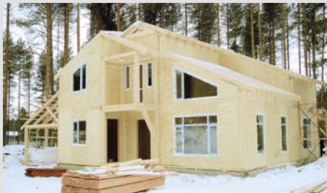
Строительство частного дома из каркасных деревянных панелей.
