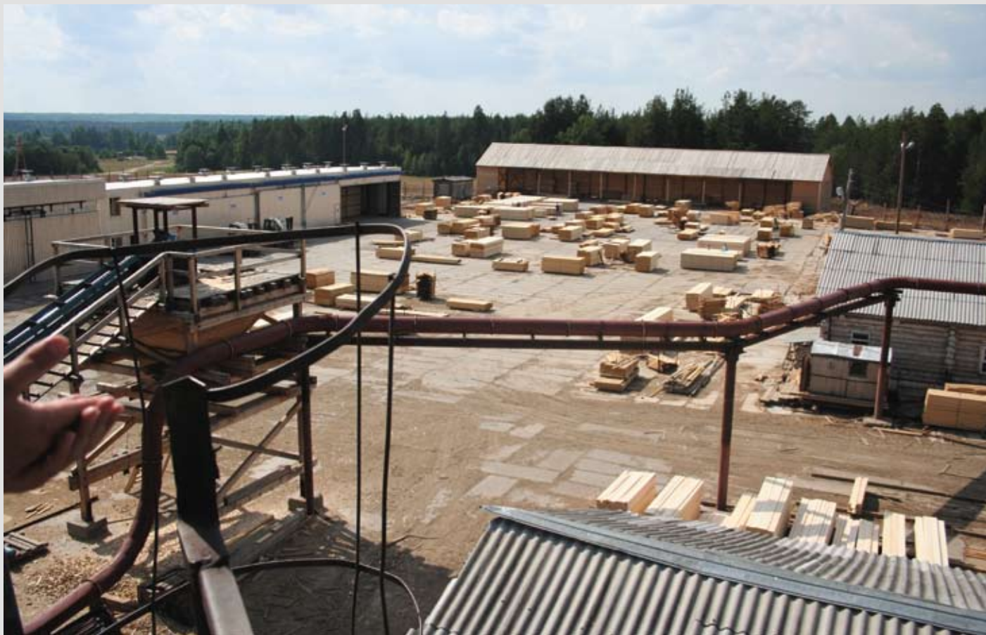
Строительство нового цеха № 2 переработки лесоматериалов на предприятии «Лузалес». п. Киддзявидзь, Прилузский р-н. 2005 г.
