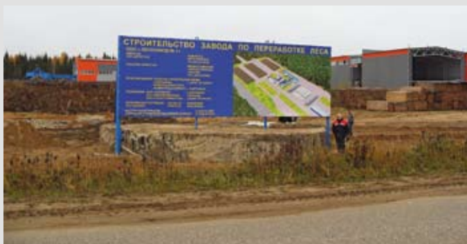
Монтаж оборудования, паспорт строительства цехов завода. Сентябрь 2009 г.
