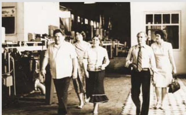
Идёт монтаж оборудования в цехе № 3 Княжпогостского завода ДВП. Представители главка Союзсплитпрома. 1981 г.
