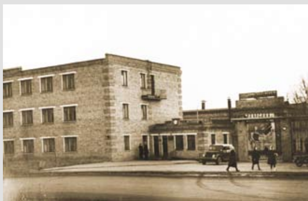
Новые корпуса механического завода. Из этих ворот на лесные делянки выходили трактора и машины. Сыктывкар. 1967 г.
