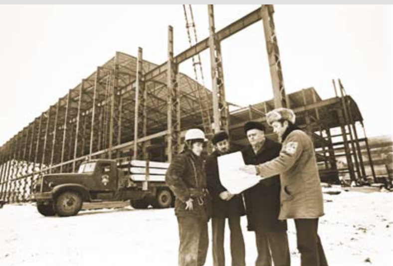
Строительство второй очереди Сыктывкарского ЛПК. Монтажники с представителями заказчика.
