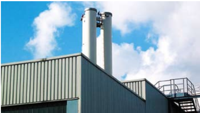
Котельная, работающая на отходах основного производства.
