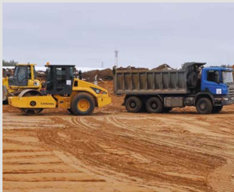
На строительной площадке.
