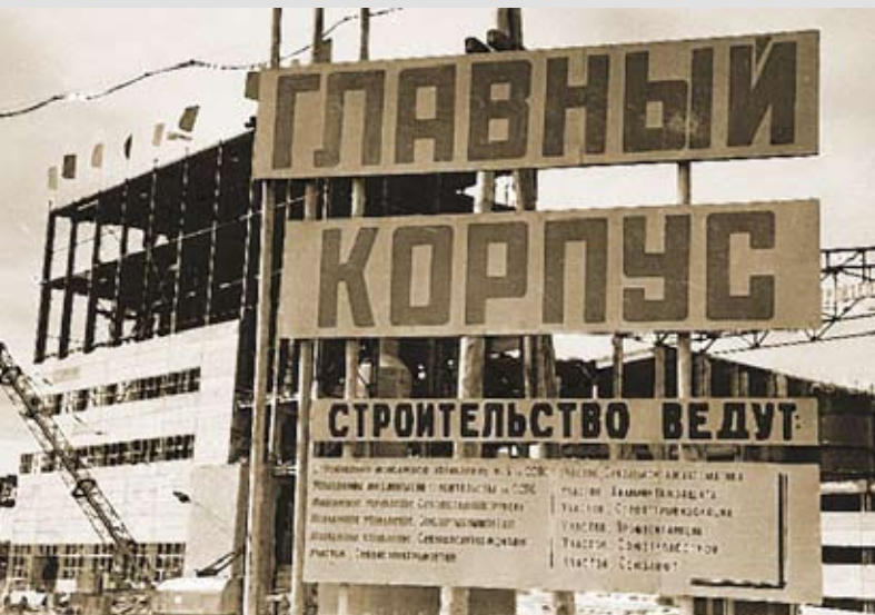
Главный корпус. Июнь.
