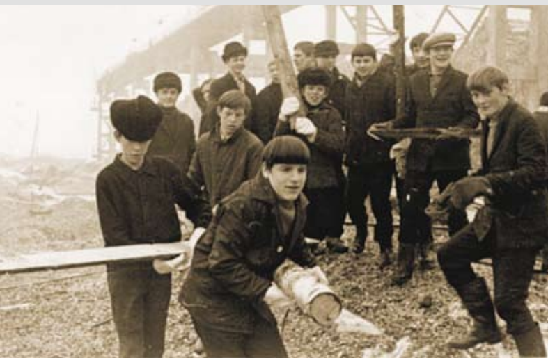
Учащиеся ГПТУ-15 на Ленинском субботнике в древесно-подготовительном цехе.
