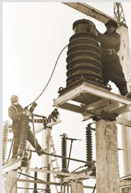
Строительство открытого распределительного устройства ТЭЦ.
