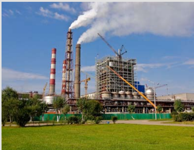
Содорегенерационный котел на этапе строительства.
