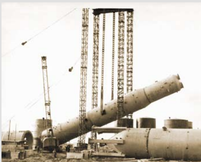
Установка варочных котлов. Середина 1960-х гг.
