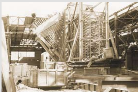
Монтаж simultанного механизма пресса. Июль 1977 г.
