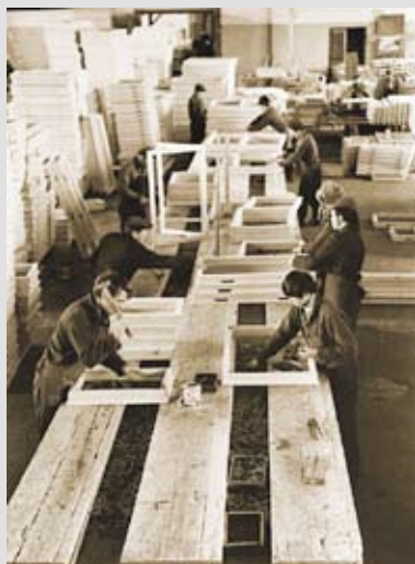
Столярно-строительный цех № 3 на Сыктывкарском ЛПК.
