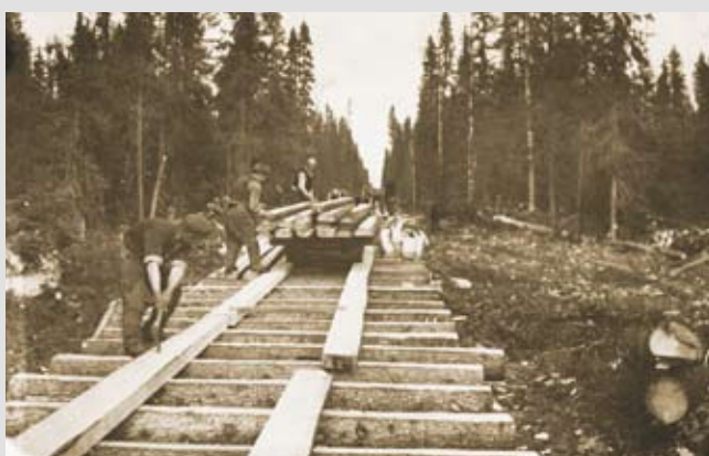
Строительство автолежнёвой дороги в летний период.
