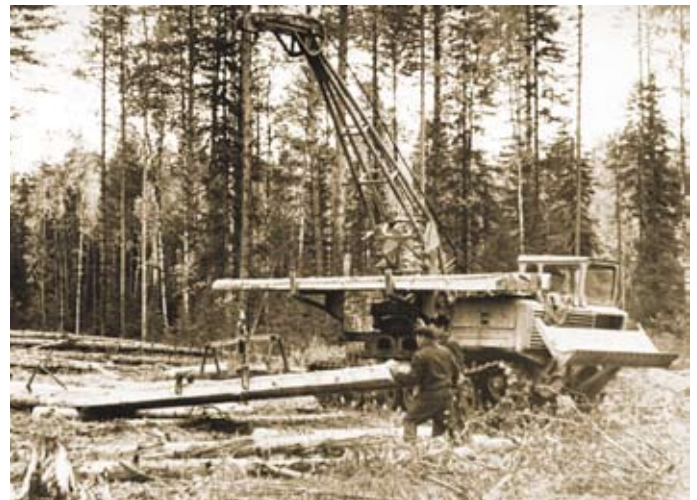
Механизированная укладка нагельных плит. Производительность труда 70-80 м за смену.
