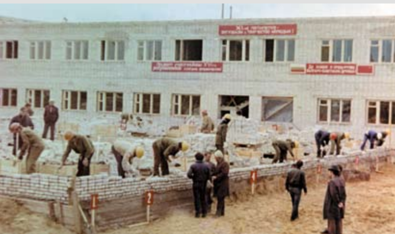
Во время конкурса молодых каменщиков на стройплощадке объекта «Столовая вышкомонтажного управления треста буровых работ».
