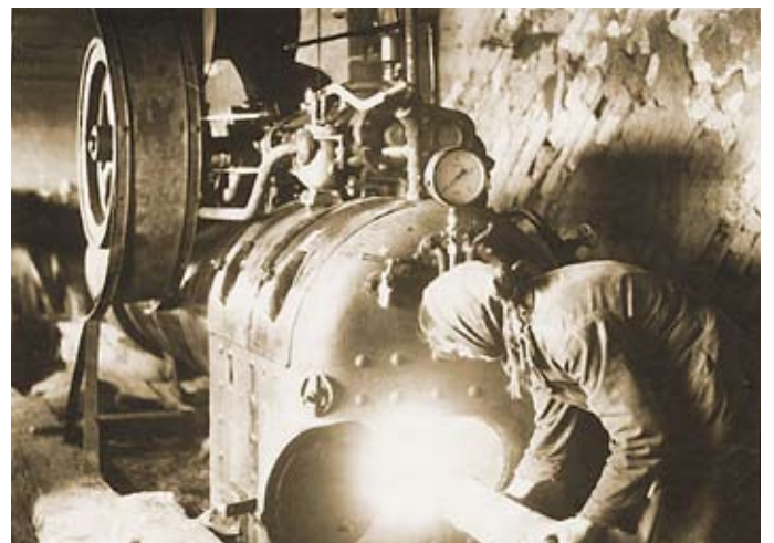
Топка локомотива для обеспечения работы двигателя пилорамы.
