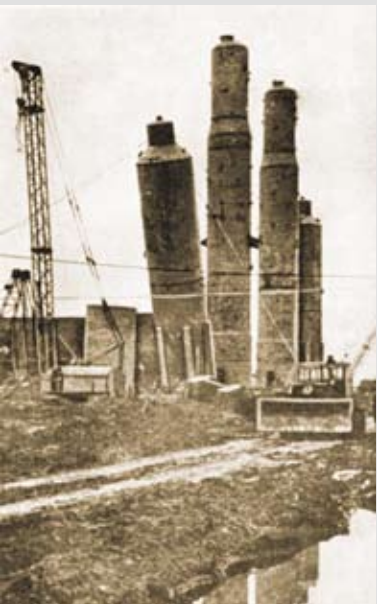
Установка варочного котла сульфат-целлюлозного завода Сыктывкарского ЛПК. 1965 г.
