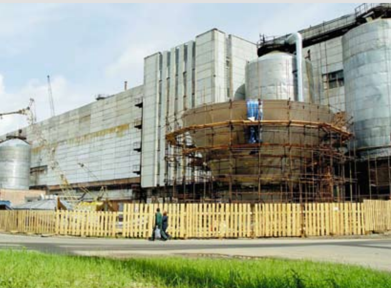
Монтаж бака целлюлозы на ОАО «Нойзидлер Сыктывкар». 15 июня 2004 г.
