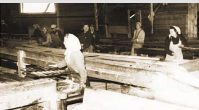
Участок торцовки пиломатериалов лесоцеха № 2 Сыктывкарского лесозавода.
