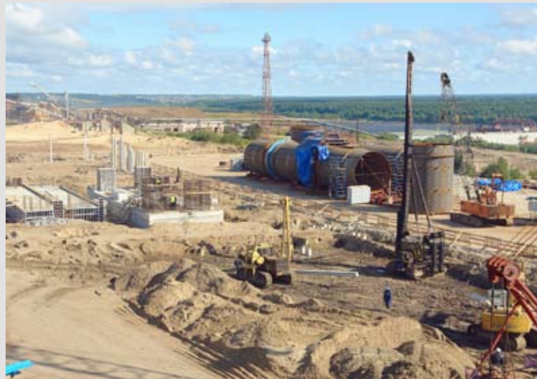
Самые большие в мире окорочные барабаны готовы к установке и монтажу при строительстве нового древесно-подготовительного цеха.
