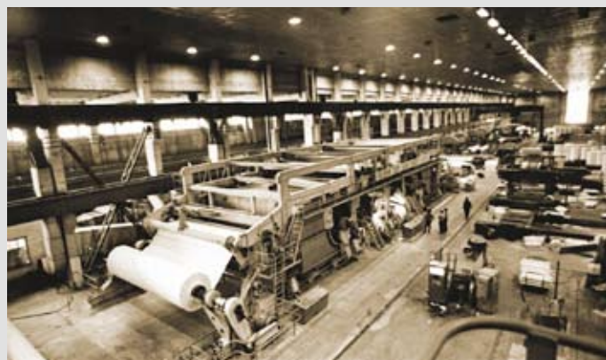
Сыктывкарский ЛПК. Вид меловальной машины. 1976 г.
