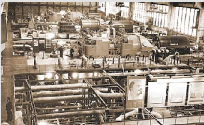
ТЭЦ Сыктывкарского ЛПК.
