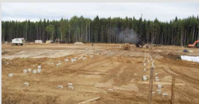
Забивка бетонных свай под фундаменты производственных цехов завода. Август 2009 г.
