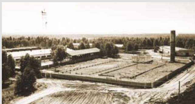
Строительство подсобного хозяйства завода ДВП. Начало 1980-х гг.
