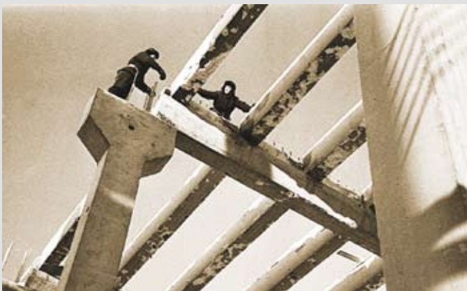
Сыктывкарский ЛПК. Монтаж склада готовой продукции. Февраль 1966 г.
