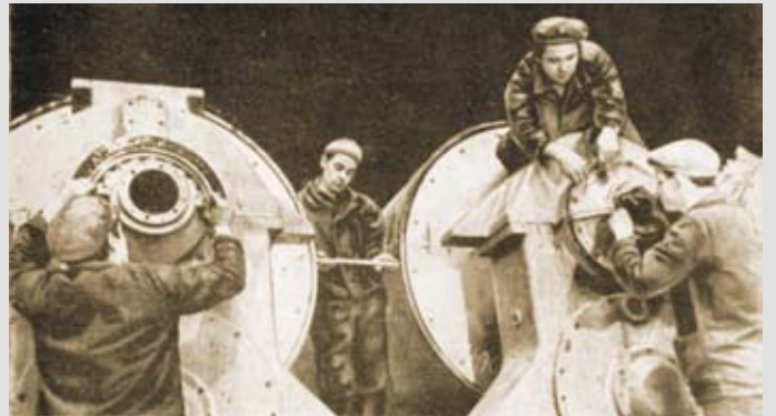
Монтажники из бригады С.Д. Сигачева (трест «Союз-промбумонтаж») на сборке цилиндров сушильной машины. Сыктывкарский ЛПК. Начало 1970-х гг.
