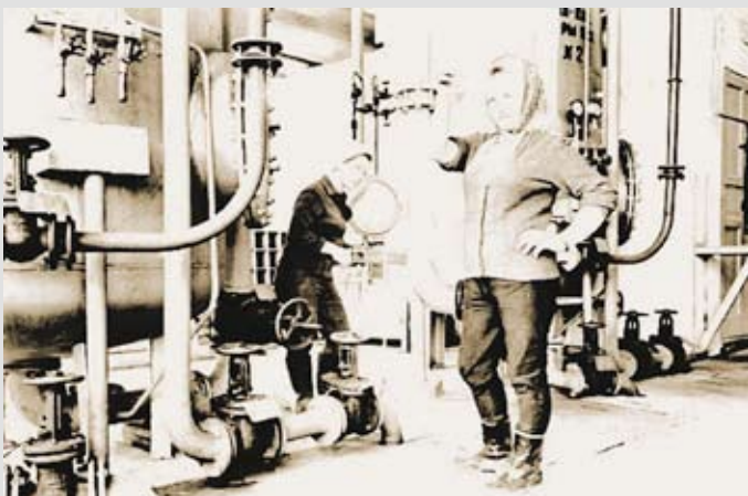
Цех химической водоочистки ТЭЦ.
