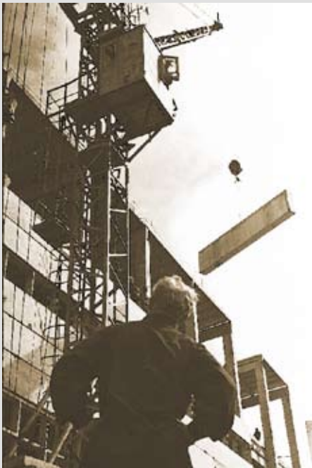
Главный корпус. Идёт монтаж панелей. Июнь.
