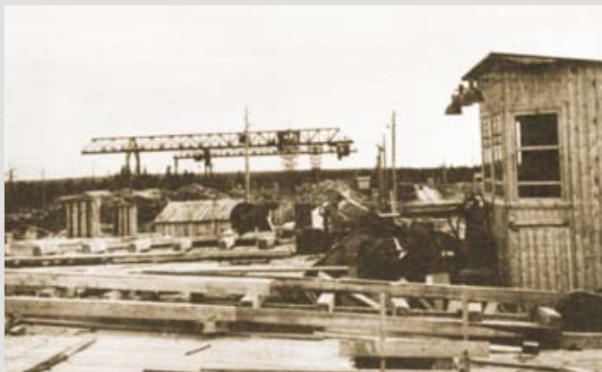
Строительство полуавтоматической линии на нижнем складе Каджеромского лесопункта. Печорский р-н. 1968 г.
