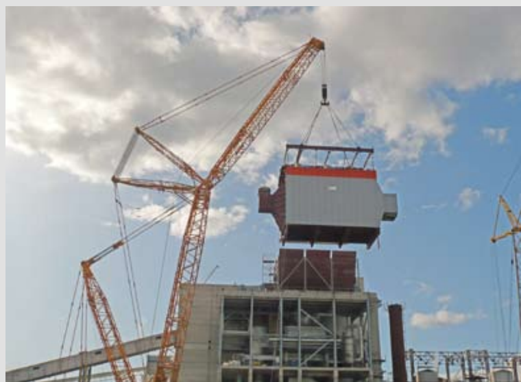
Подъем фильтра на известерегенерационную печь.
