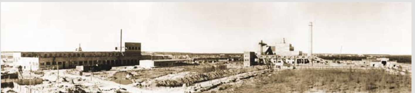
Завершение строительства первой очереди цеха № 1 и котельной Княжпогостского завода ДВП. 1971 г.
