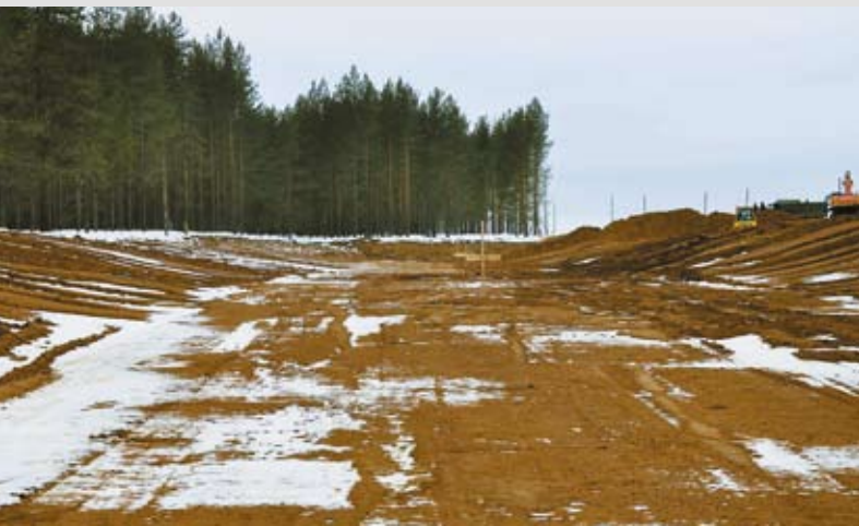
Начало осуществления проекта: подготовка строительной площадки.
