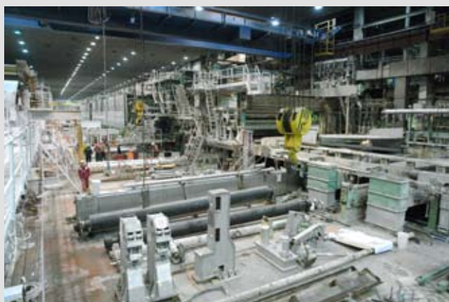
Картоноделательная машина на этапе реконструкции.
