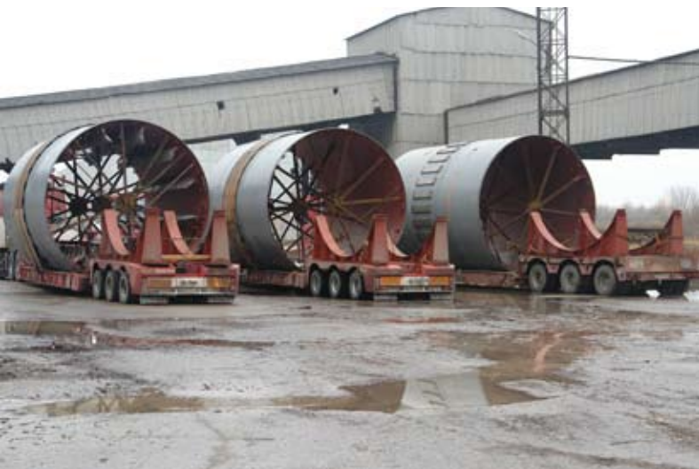
Известерегенерационная печь «прибыла» на Сыктывкарский ЛПК в разобранном виде. Обечайки ИРП подготовлены к монтажу.
