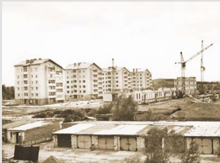
Строительство микрорайона № 3 жилого массива Княжпогостского завода ДВП. 1984 г.
