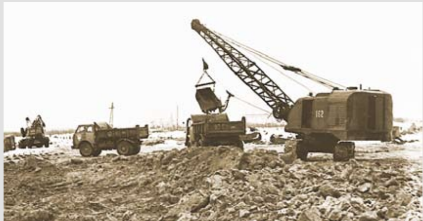
Выемка грунта под фундамент второй очереди Сыктывкарского ЛПК. 1971 г.
