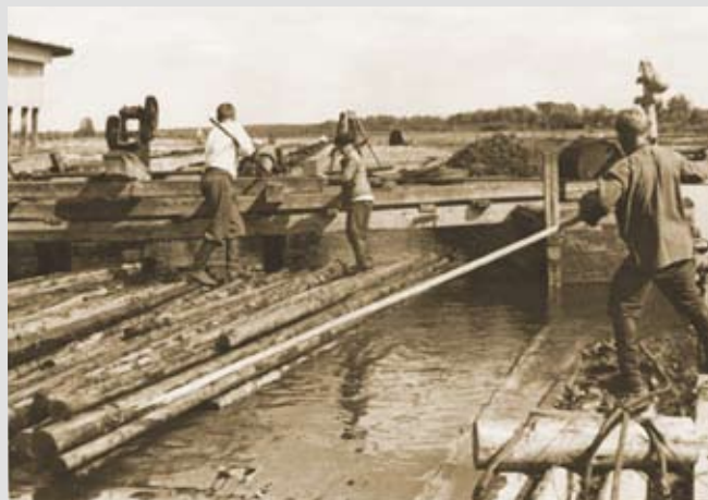
Механизированная сплотка леса посредством станка Снеткова в Максаковской запани. 1939 г.
