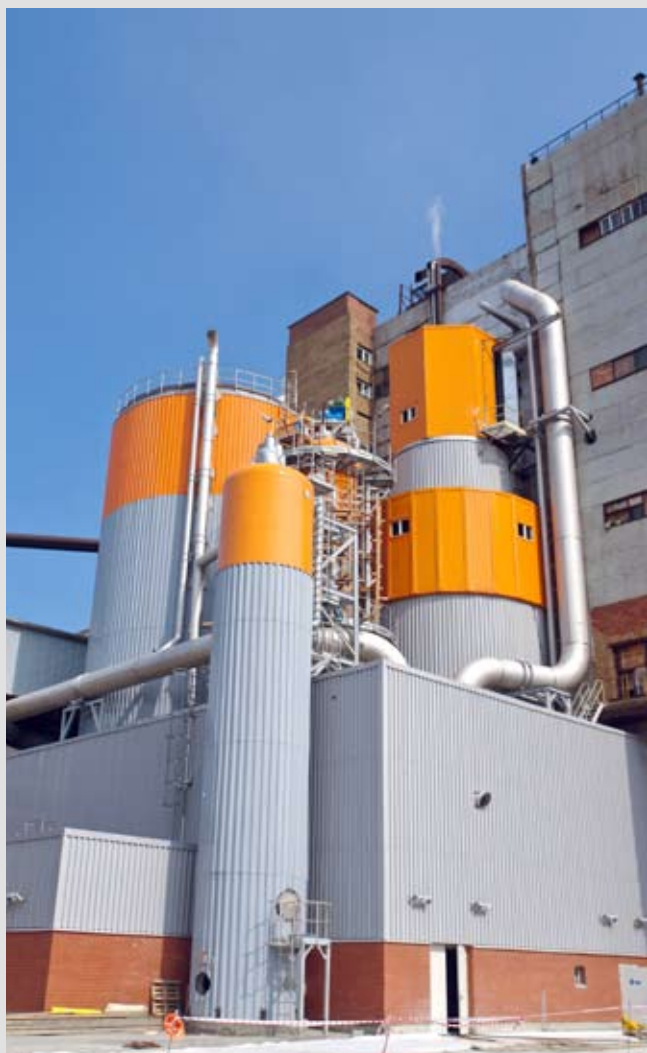
Варочно-отбельный цех на этапе реконструкции
