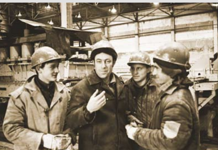
Строительство фанерного завода и цеха древесностружечных плит на Сыктывкарском ЛПК. Бригада А.Н. Гречушников (в центре) со своей бригадой монтажников Сыктывкарского монтажного управления треста «Союзпромбуммонтаж». 1976 г.
