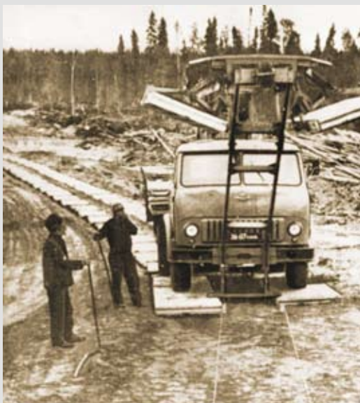
Сооружается трасса для лесовозов.
