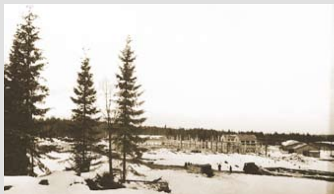
Идёт строительство домостроительного предприятия базы стройиндустрии. Сыктывкарский ЛПК. 1963 г.
